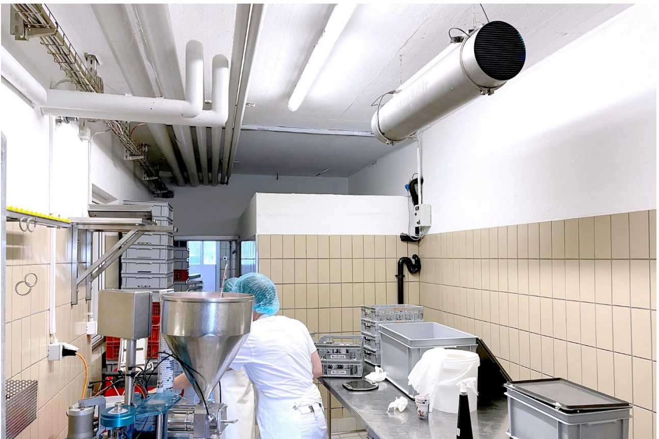
Der UVR-4K sorgt bei der Abfüllung der Joghurts für die nötige Lufthygiene im Raum. Dank Schutzraster ist die Arbeitssicherheit in Fabrikationsräumen mit dauerhaftem Aufenthalt von Personal gewährleistet.
