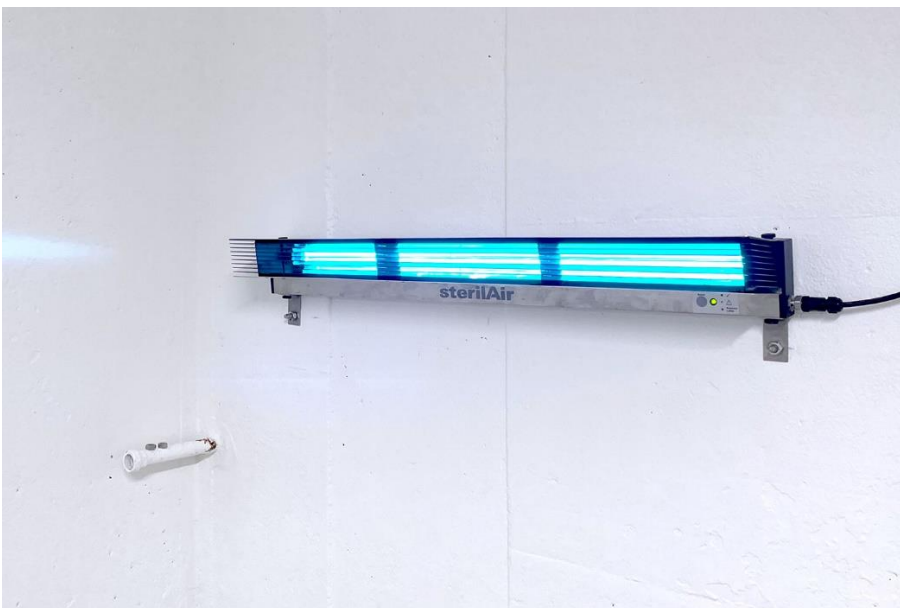
Bei der Reifung der Weichkäsespezialitäten werden Schimmelsporen in der Luft mit einem sterilAir WR Wandstrahler inaktiviert.
